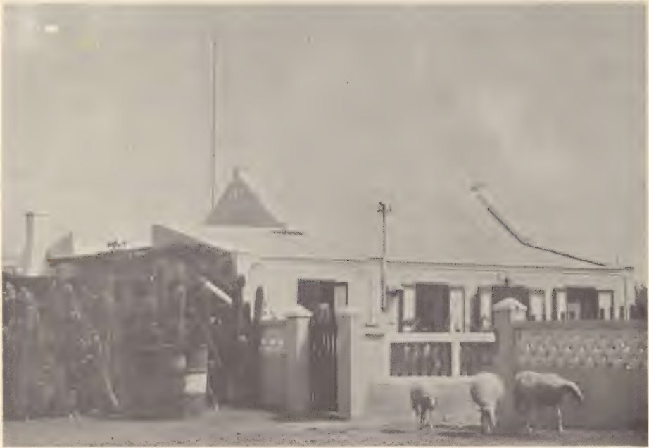
Woonhuis te Ponton gebouwd in 1923 pannendak vervangen door gegolfde asbestplaten. Let op versierde pilasters en gepleisterd fries
